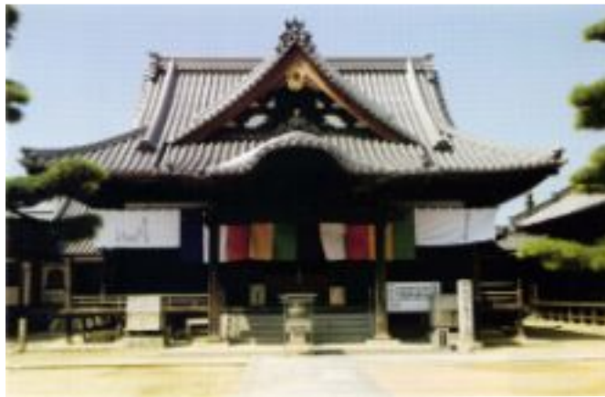
改修された長尾寺本堂
